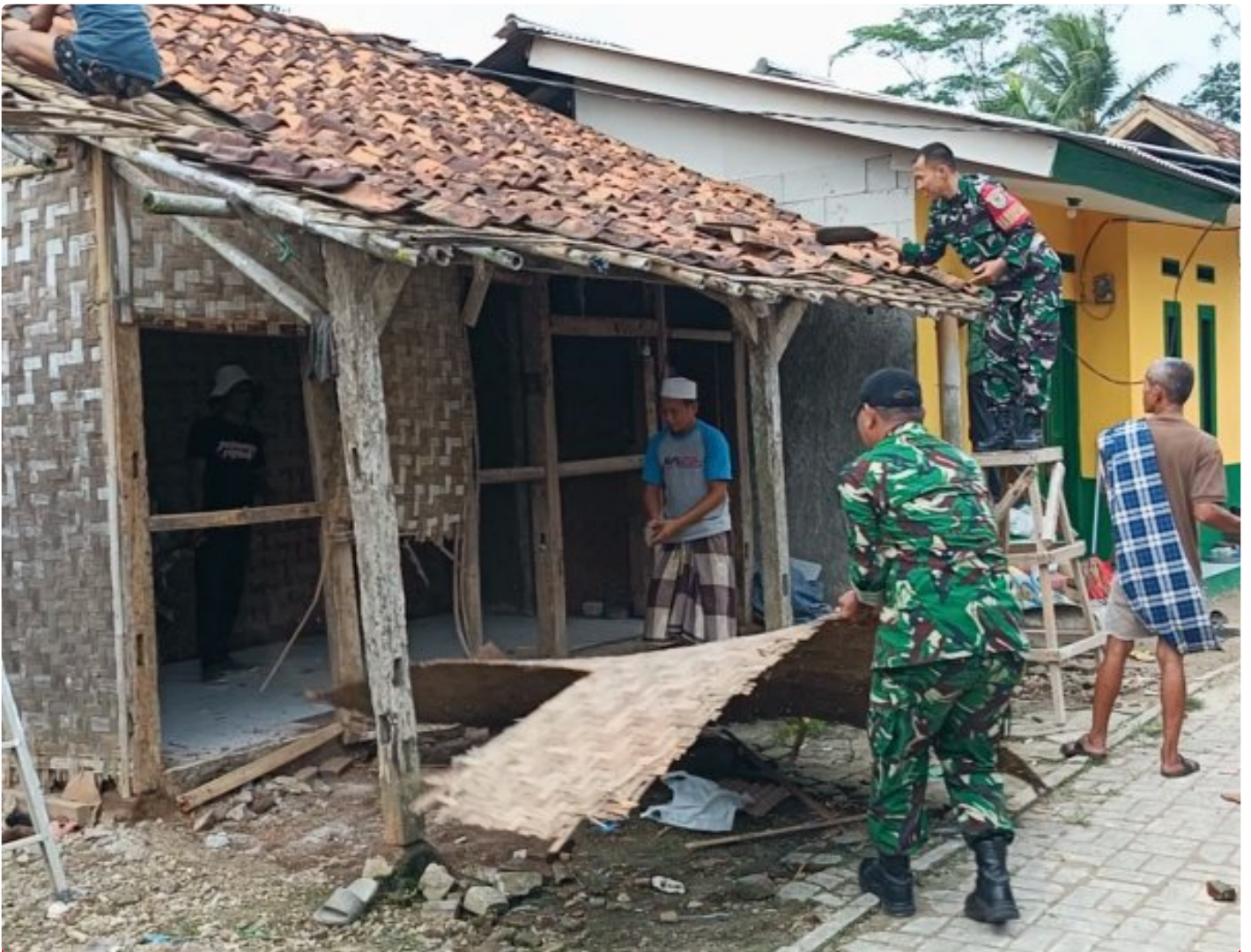
Pembongkaran Rumah Bapak Narmin
